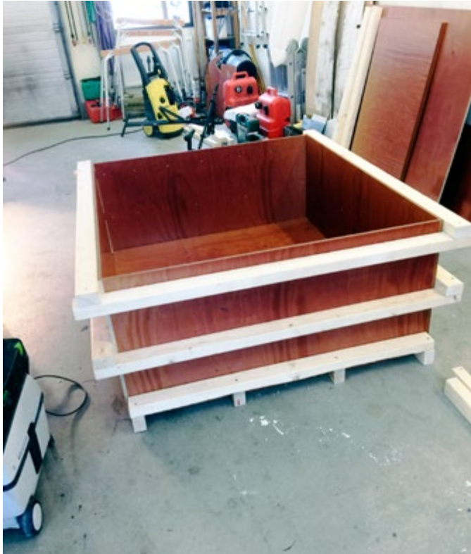
Hamn- och farledskommittén förbereder gjutning av bojtyngder för Roslagskusten. Foto Kurt Sjöberg.
